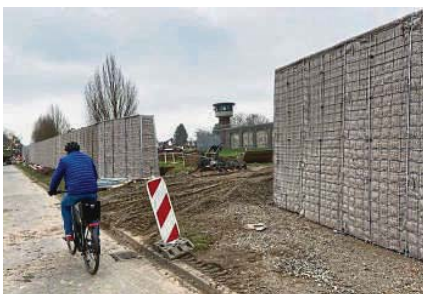
Sicht- und Lärmschutz an der Windmühlenstraße: Die Baumaauer ist drei Meter hoch, 150 Meter lang und soll begrünt werden.
