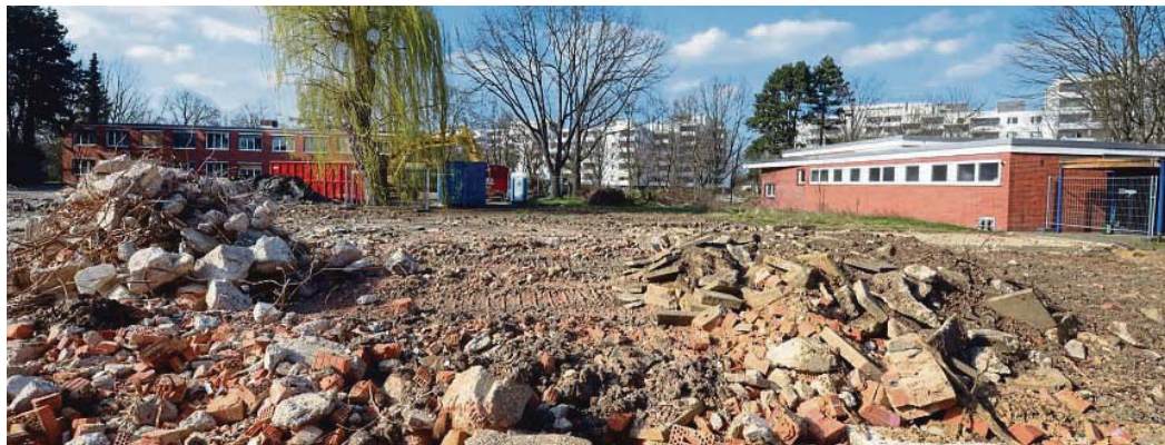
Soll bis April Geschichte sein: Die ehemalige Heinrich-Steuil-Schule im Stadtteil Forstfeld.
