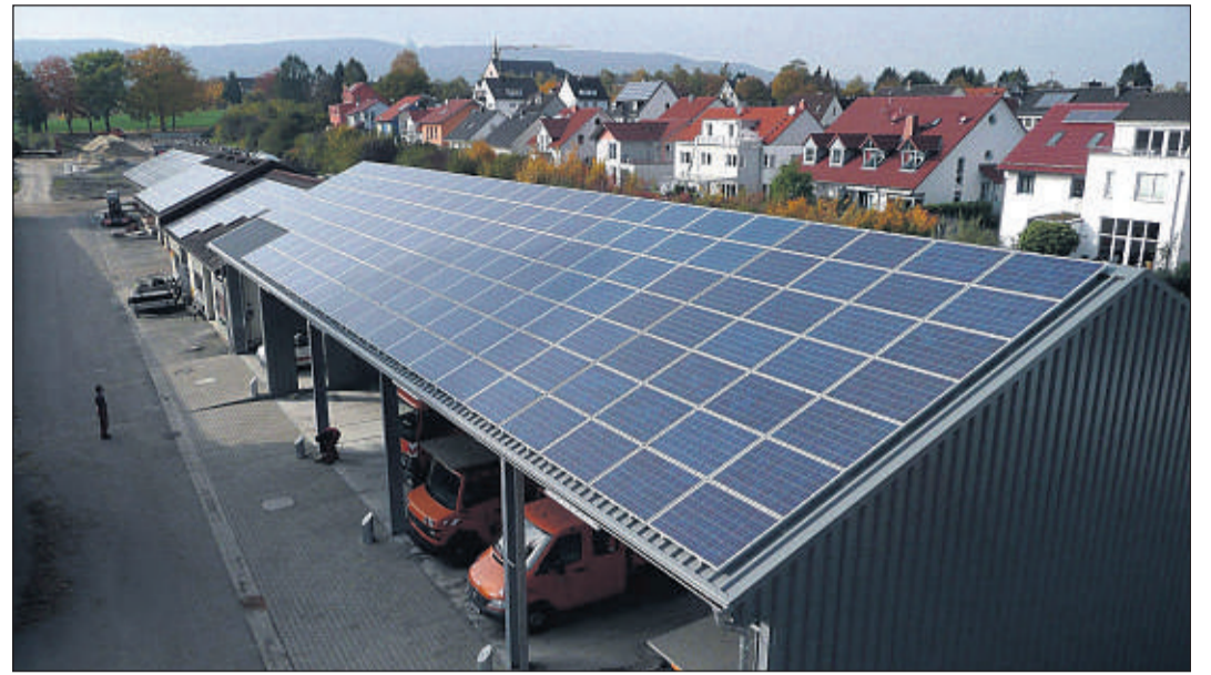
Hilft dabei, in der Solarbundesliga weiter aufzusteigen: Auf der Dachfläche des Gartenamts in der Bosestraße wurden Photovoltaikmodule angebracht.
